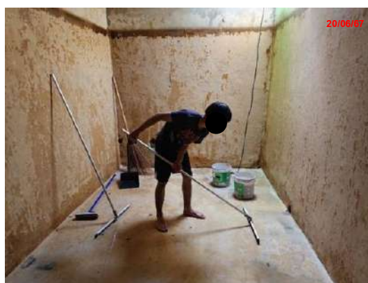
ภาพที่ 2.2-22 การทำความสะอาดถังเก็บน้ำสำรอง
