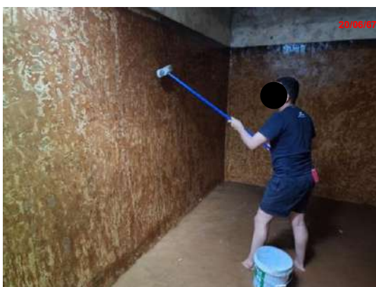
ภาพที่ 2.2-22 การทำความสะอาดถังเก็บน้ำสำรอง
